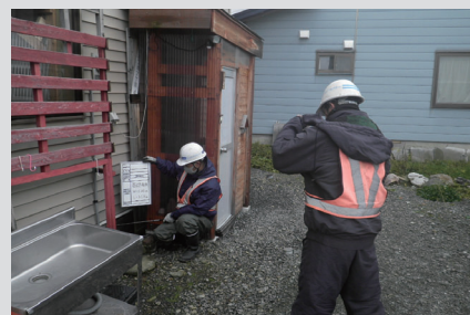
家屋損傷調査
