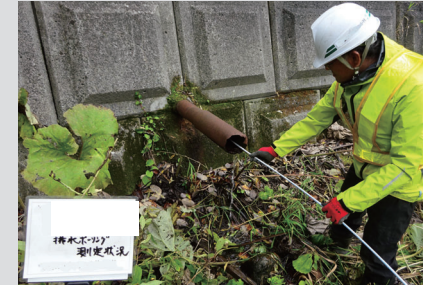
地すべり施設点検
