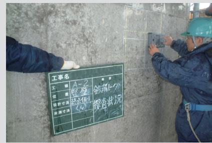
鉄筋レーダ探査
