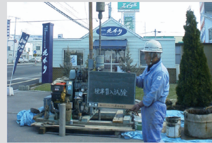
ボーリング調査
