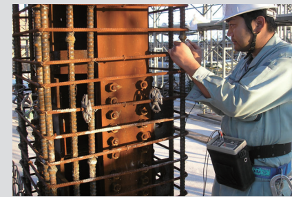
超音波探傷検査
