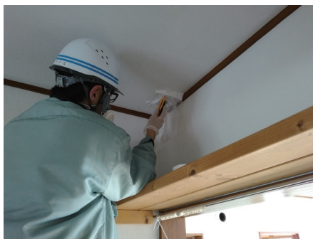
アスベスト調査
